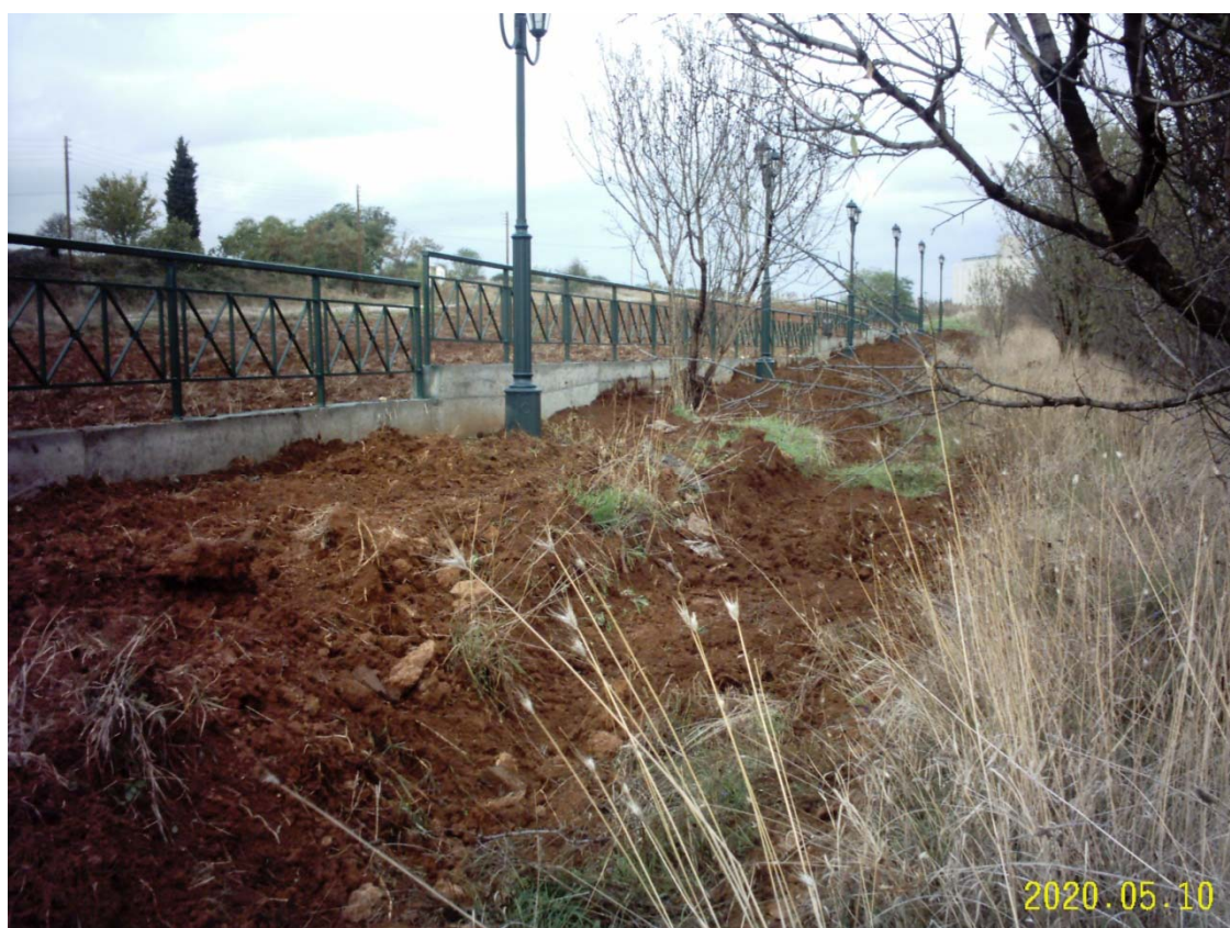
ΣΙΔ. ΣΤΑΘΜΟΣ ΚΙΛΚΙΣ (ΚΡΗΣΤΩΝΗ)
